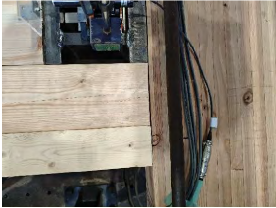
(1) 1/150rad 時 1層右側添柱割れ
