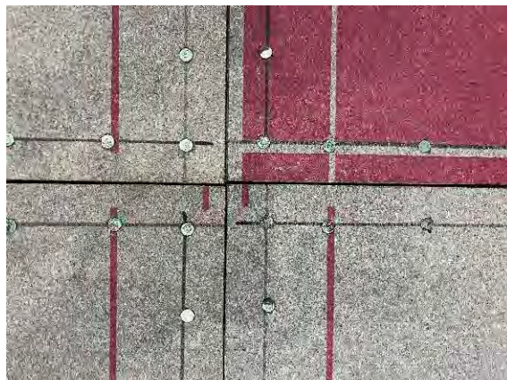
(4) 加力終了時 3層中央面材継手部
