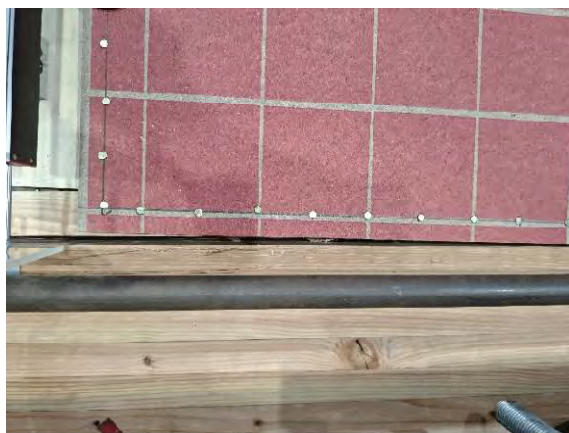
(3) 加力終了時 2層左側壁脚部
