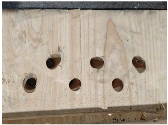
(4) CLT 側接合面 (内側)
