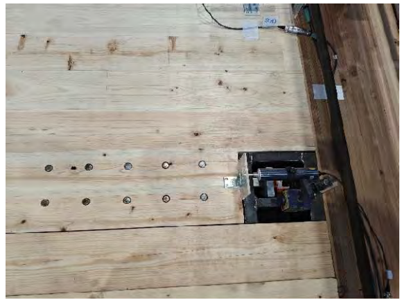
(4) 加力終了時 右側 CLT 壁頭部
