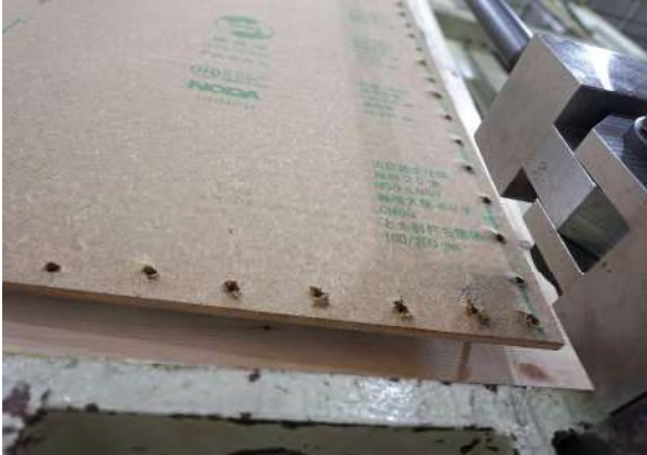
右面材オモテ側 面材くぎの引抜け
