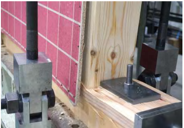
右柱脚部 下枠へのめり込み・割裂
