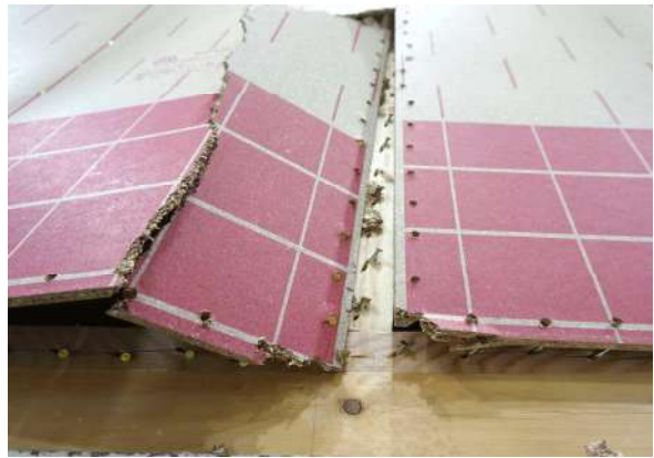
オモテ側面材継手下部 ぐり頭のパンチングアウト
