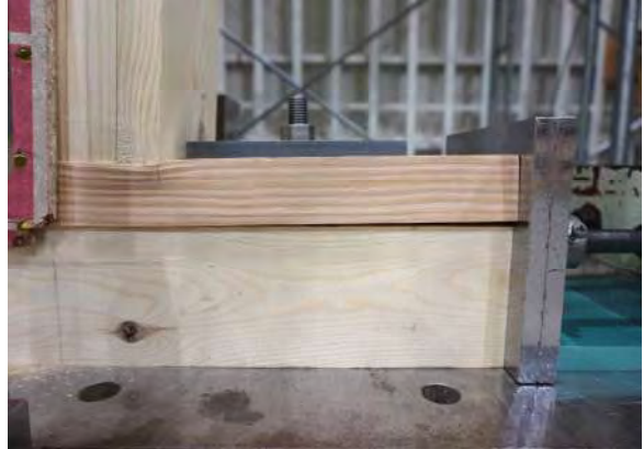
右柱脚部 下枠へのめり込み
