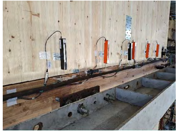
(8) 1/75rad 時 CLT—横架材間浮き上がり
