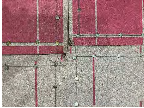
(6) 加力終了時 2層中央面材継手部
