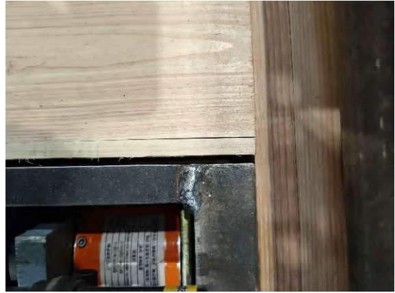
(2) 1/50rad 時 右側 CLT 壁頭端部割れ
