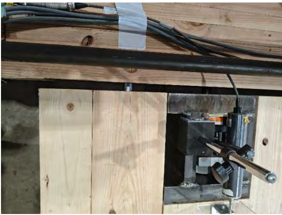
(3) 加力終了時 左側 CLT 壁頭端部
